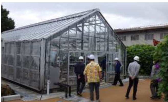
写真 18 栽培温室 B 改修工事（都工事）
