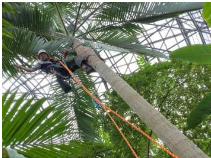
写真 13 ロープワークによる高所作業
