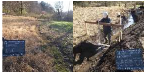
写真 13, 14 整備前(左)、整備後(右)
