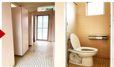
扉の改修、便器の洋式化、ペーパーホルダーの更新など利便性が大幅にアップ!!
