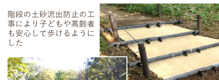
山側からの流水によるぬかるみ対策は水はけを確保しつつ歩行可能な施工で解決した
