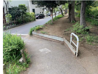
防護柵がない状態の作業前
