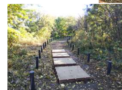
階段の土砂流出防止の工事により子どもや高齢者も安心して歩けるようにした
