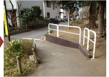
鉄板を擬木柵に交換した作業後
