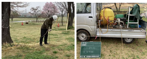
エンジンポンプを用いた灌注作業
