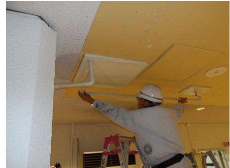
雨漏り対策工事
