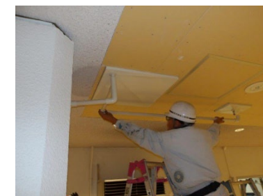
雨漏り対策工事
