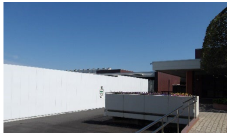
改築工事中の瑞江葬儀所
