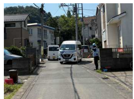
写真－2 狹隘な資材搬入経路
