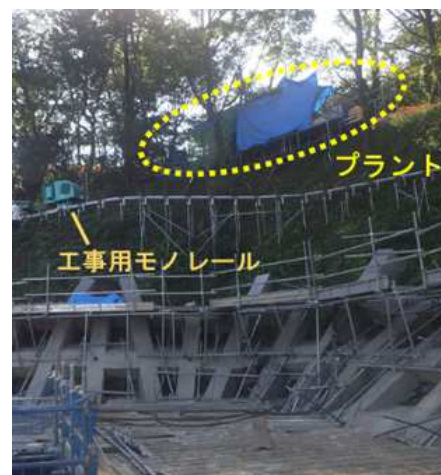
写真－3 プラント設置状況
