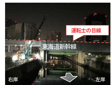
写真－2 鋼管杭圧入(右岸)
