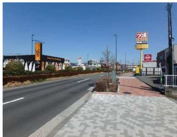
都道における無電柱化の例(多摩ニュータウン通り) (出典：東京都南多摩西部建設事務所の概要(令和6年度版))
