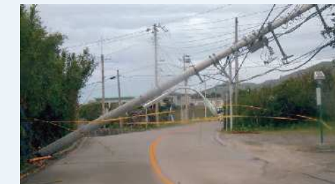
写真：令和元年台風15号の影響による電柱倒壊（新島村若郷地区）
