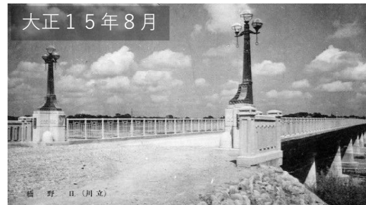
日野橋しゅん功 大正期の三大鋼桁橋の1橋
