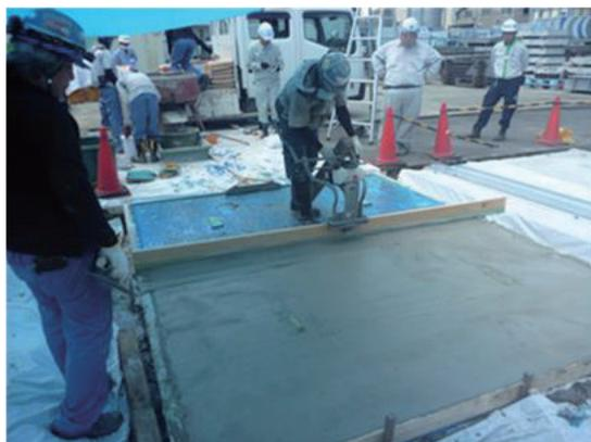
写真-9 タイプCの締固め仕上げ状況
