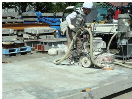
写真-8 タイプBの研磨機再仕上
