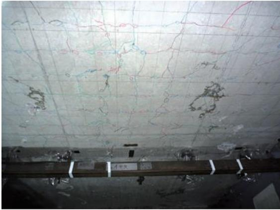
写真-10 タイプBの漏水状況
