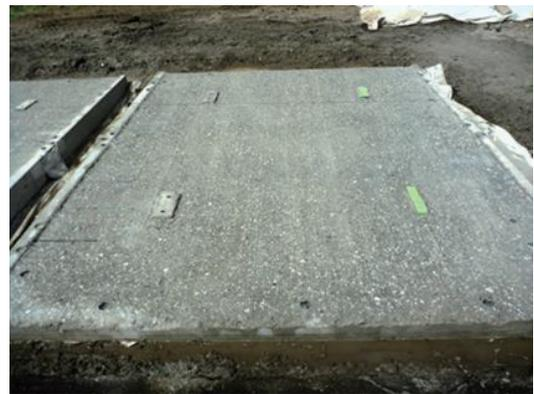
写真-4 20mm 切削完了
