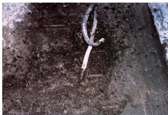
写真-1 過切削による鉄筋損傷
