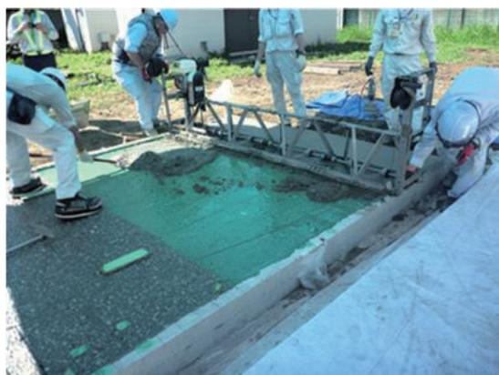
写真-6 タイプBの振動締固め状況
