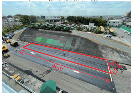
写真-1 場内試験路面施工状況
