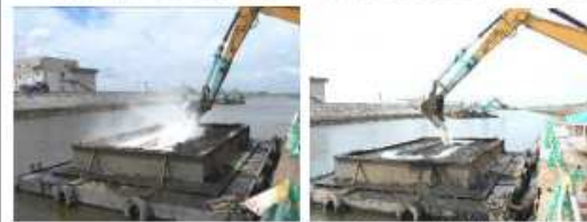
図-4 現場での飛散状況比較
