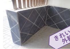
開放公園トイレ壁補修
