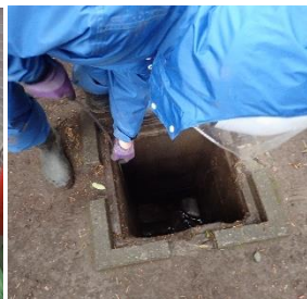
毎雨ごとの確認と必要に応じた排水系統の清掃作業
