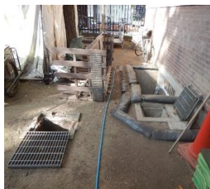
毎雨ごとの確認と必要に応じた排水系統の清掃作業
