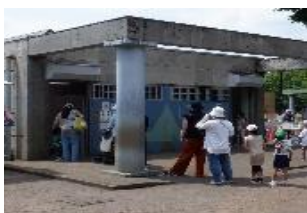
トイレ入口部の段差を解消。残った段差に黄線を付けて視認性向上。
