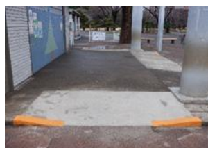
トイレ入口部の段差を解消。残った段差に黄線を付けて視認性向上。
