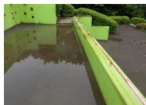
わんぱく山の雨後のぬかるみは、不陸整正と舗装で排水性向上。
