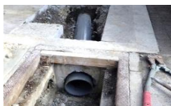
排水溝連結工事
