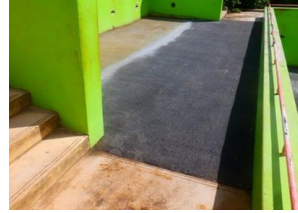
わんぱく山の雨後のぬかるみは、不陸整正と舗装で排水性向上。
