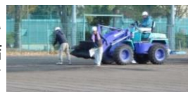
土の敷き均し
