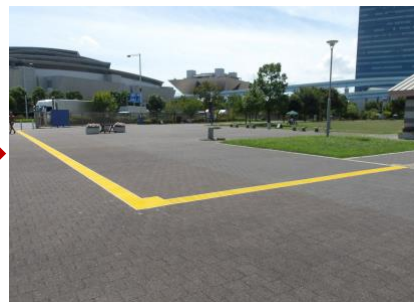
点字ブロック設置後
