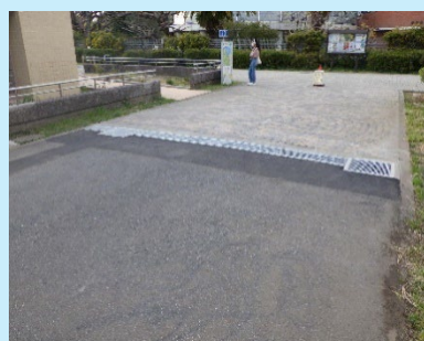
排水工事実施
