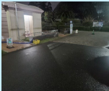
園路冠水の排水対応ポンプ設置
