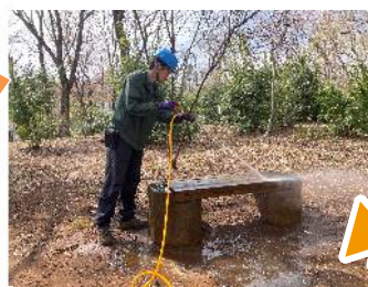
公園入口のベンチに高圧洗浄を実施
