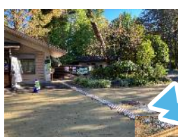
点字ブロックを改修
