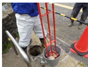
接続桝の浚渫
