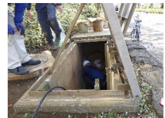
北側処理施設 高圧洗浄
