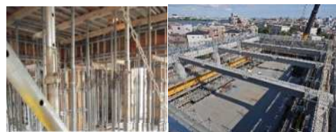
図4_型枠支保工
