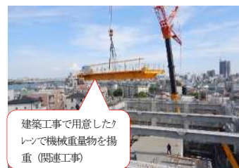
図8_揚重機の共用
