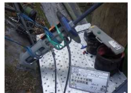
写真1 リフトオフ試験状況
