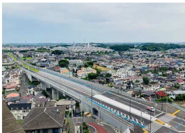
写真－1 橋梁部全景
