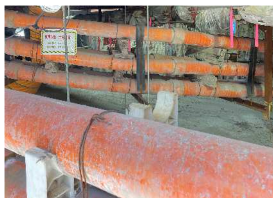
写真—1. 橋脚施工箇所に隣接した立坑内
