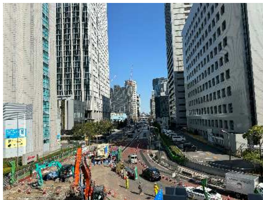
写真―2. 現道部の工事状況
