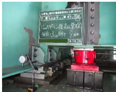
写真 2 支承取替の状況
