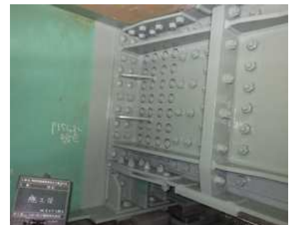
写真 3 箱桁部の端横桁補強
