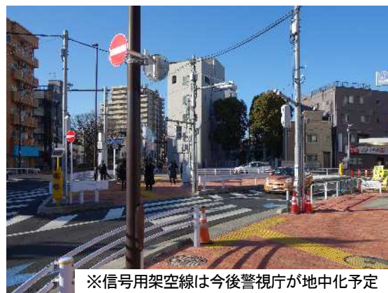
図-4 事業完了後の様子（手前が左折専用レーン）
