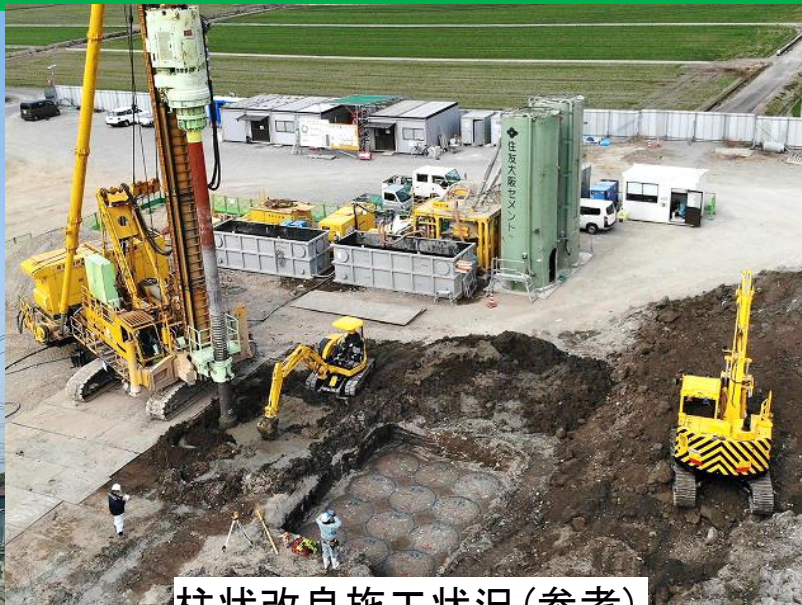
柱状改良施工状況(参考)
