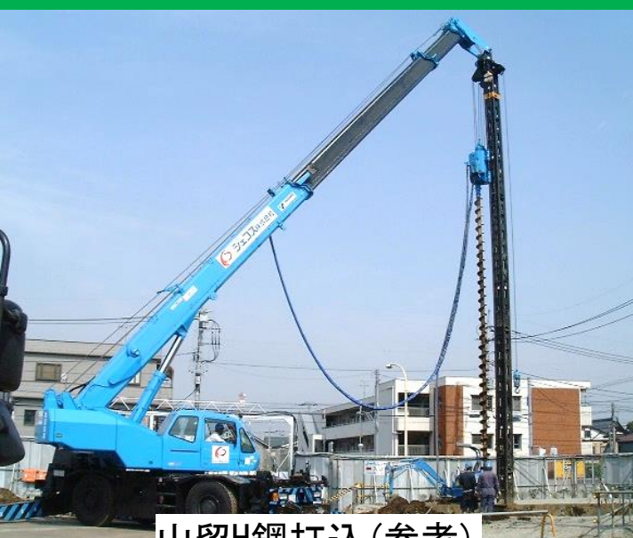
山留H鋼打込(参考)
