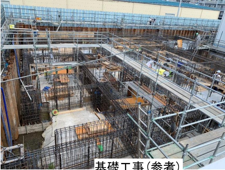
基礎工事(参考)
