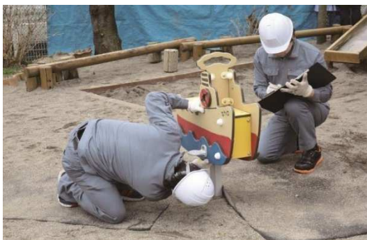
写真1 専門業者による点検
