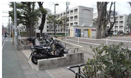
自転車置場と傾斜路 広場内への自転車乗 入を禁止し、置場を整備。高低差がある ので傾斜路を整備している。
