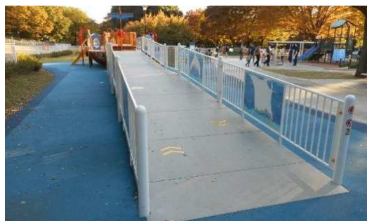
「みらい号」の幅2mのスロープ 車いすですれ違える広さがあり、海をイメ ージしたパネルで演出している。
