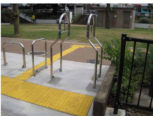
車いす対応の車止め
