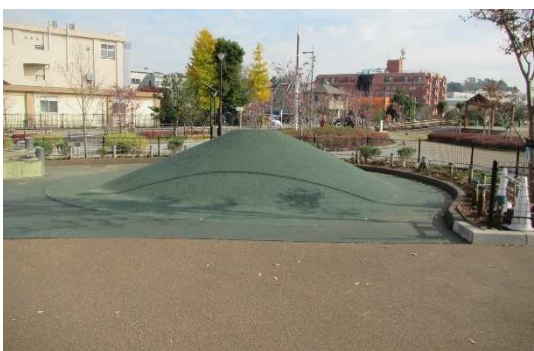
ゴムチップ系舗装の築山 這って登ったりすることができる。
