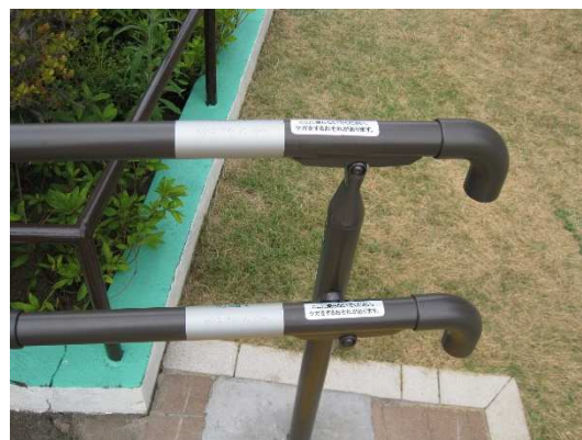
手摺端部の点字表示
