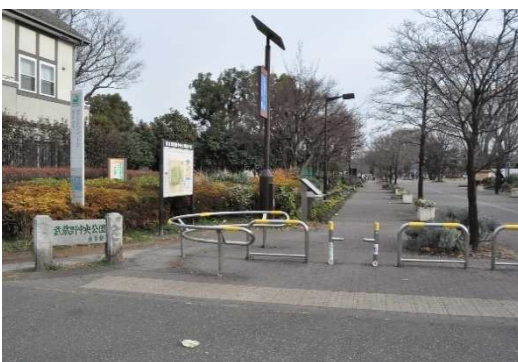
写真3 公園出入口(3) バイク進入防止が厳重な出入口は、車いすへの十分な配慮が必要。(都立武蔵野中央公園)
