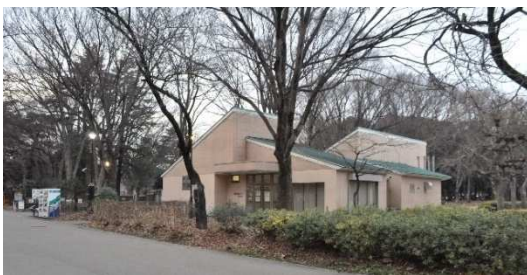
写真3 管理事務所 できるだけ広場に近い位置関係が望まれる。広場との距離は約400m。（都立砧公園）
