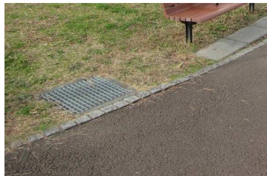
写真4 排水溝（ます） 園路の外側に設置されている。（世田谷区立二子玉川公園）
