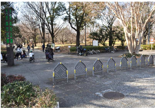
写真1 公園出入口(1) 段差がないこと、車いすの走行に車止めが支障ないこと等が重要。(都立砧公園)
