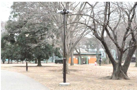
写真1 放送設備 広場近くにあり、閉園時間を知らせる。(都立砧公園)
