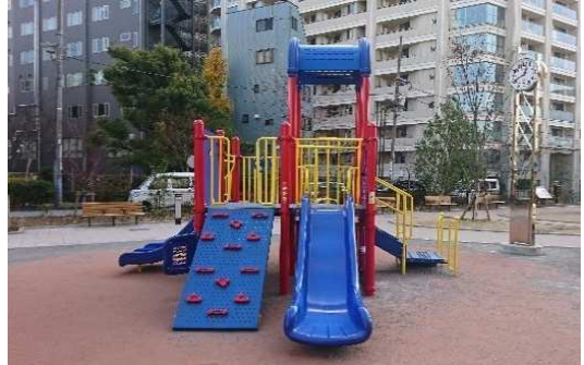
写真4 小さな複合遊具 幼児用。5m×8m程度。車いす用スロープはない。右側の階段部は移乗用デッキとなっている。(中央区立築地川公園)
