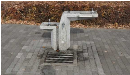
写真1 水飲み（1） 飲み位置の高さの異なる水栓が2カ所、そのほかに手洗いがついている。（都立光が丘公園）
