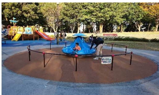
写真3 回転遊具設置面の舗装 安全領域以上にゴムチップ舗装（都立砧公園）
