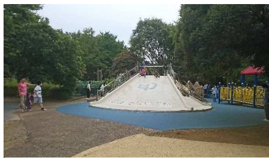
写真4 滑り台設置面の舗装 安全領域にゴムチップ舗装（国営昭和記念公園）
