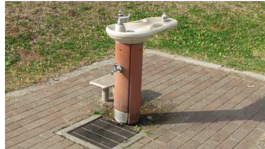
写真2 水飲み（2） 飲み位置の高さは1カ所だが、足台がついている。開閉しやすいレバー式。（世田谷区立二子玉川公園）
