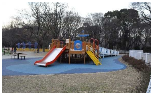
写真2 複合遊具設置面の舗装 安全領域全域にゴムチップ舗装（都立砧公園）
