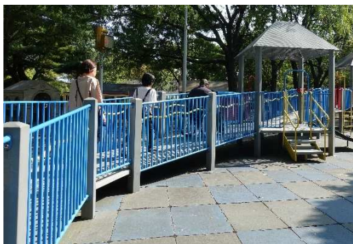
写真6 複合遊具設置面のゴムマット舗装（Playground for All Children ニューヨーク市）
