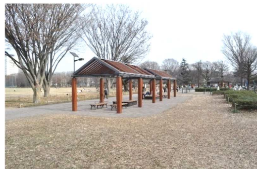
写真3 広場沿いの休憩所 木調の落ち着いた雰囲気休憩所。テーブル、ベンチなどが配置されている。 (都立武蔵野中央公園)
