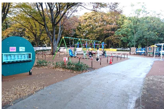
写真1 幹線園路(1) 舗装材はアスファルト。色彩は明るいグレー系。幅員は車いすがすれ違える 1.8m。(都立砧公園)
