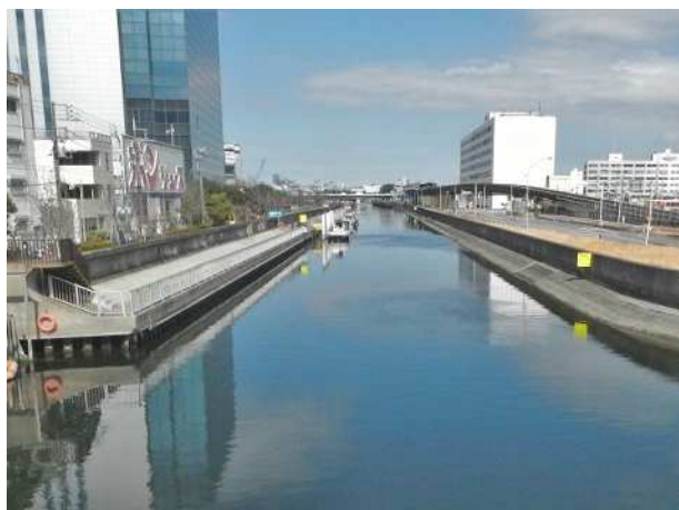
海老取川（穴守橋下流）
