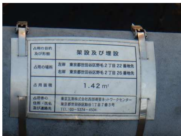
ガス管の占有許可標識（丸子川）
