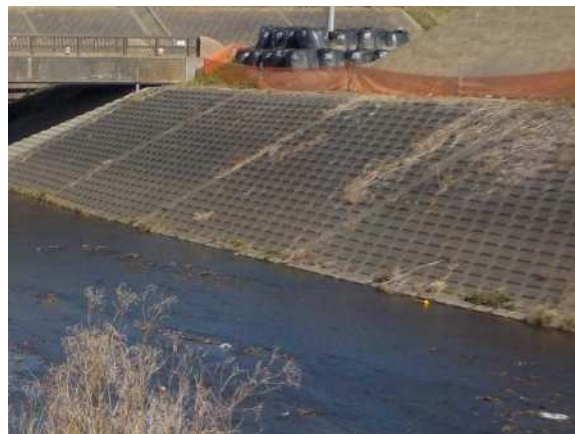
コンクリートブロック張護岸（谷沢川河口）
