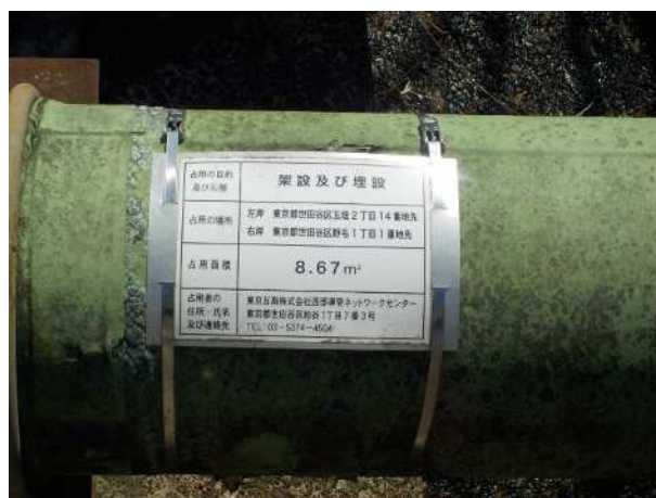
ガス管の占有許可標識（谷沢川）
