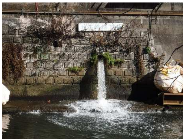
地下鉄地下水の導水（目黒川）
