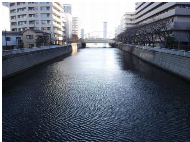
目黒川（洲崎橋下流）
