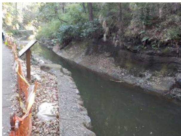
谷沢川（ゴルフ橋下流）
