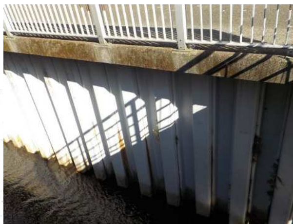
鋼矢板護岸（谷沢川）
