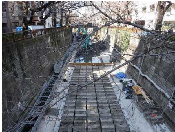
目黒川河床整備工事
