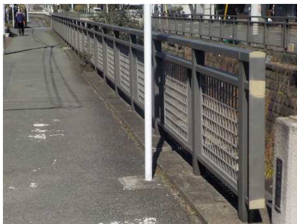
転落防止柵（谷沢川）
