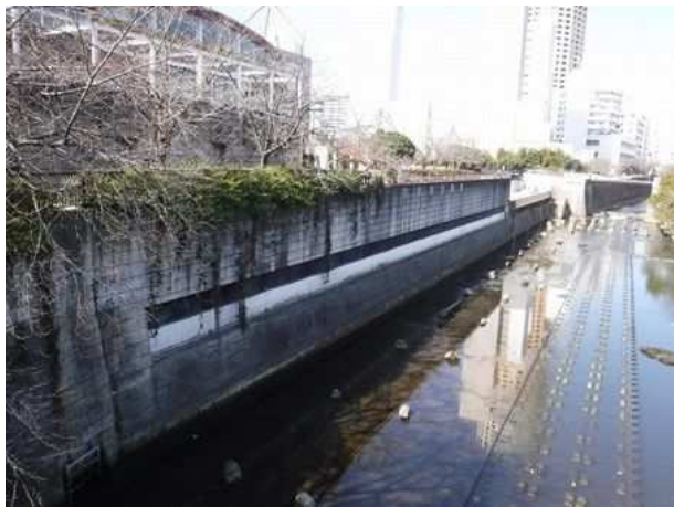
船入場調節池(下部：越流堤)
