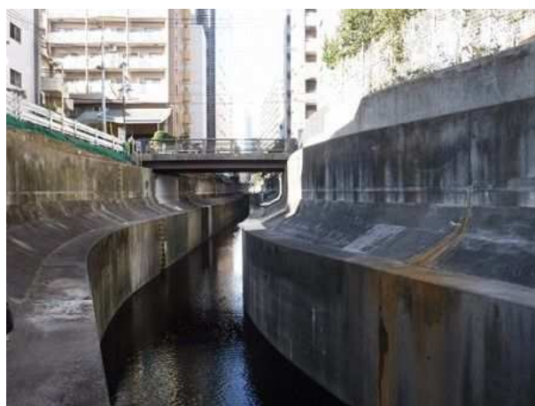
コンクリート護岸（渋谷川）
