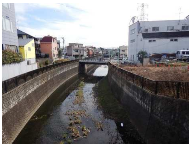
仙川（仙川橋下流）
