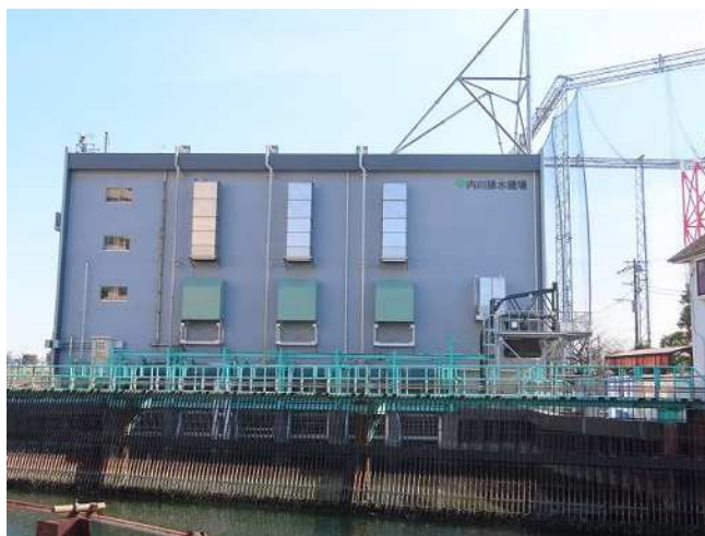
内川排水機場
