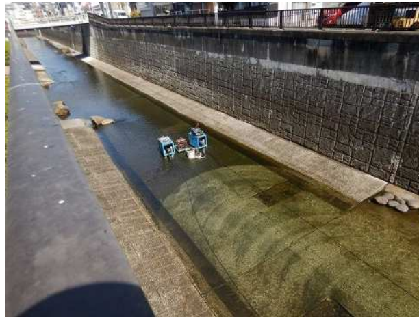
河床の清掃（呑川）
