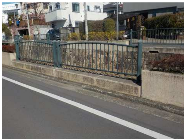
転落防止柵（丸子川）
