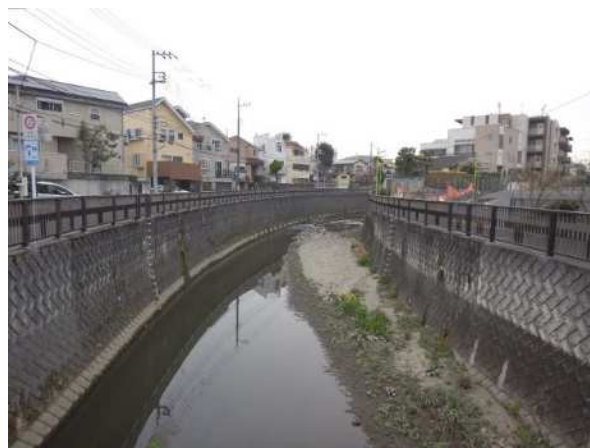
コンクリートブロック積護岸（仙川）
