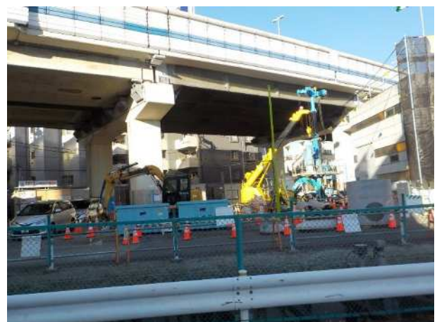
取水施設工事現場(世田谷区玉川台一丁目)
