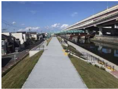
綾瀬川（緩傾斜堤防整備）
