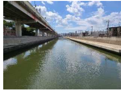
綾瀬新橋より下流を臨む 耐震護岸完了箇所
