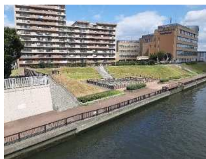
スーパー堤防 尾竹橋下流左岸
