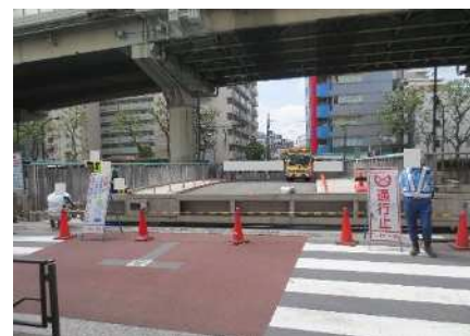
中之橋左岸陸閘
