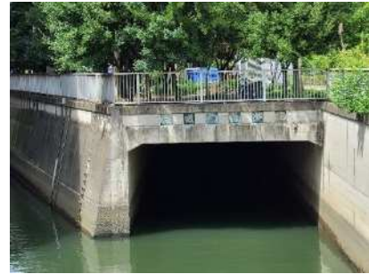
水道橋分水路（吐口）
