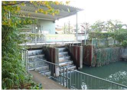
旧小溜井排水機場
