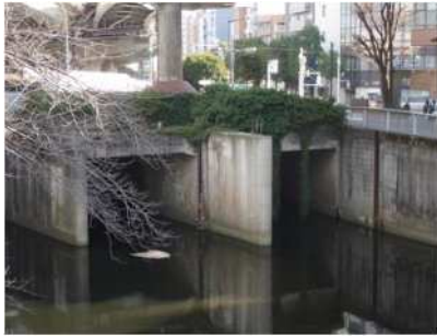
江戸川橋分水路（呑口）
