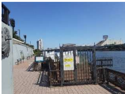
桜橋防災船着場
