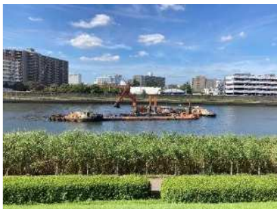
流下断面の確保 しゅんせつ状況 (隅田川 汐入大橋上流)
