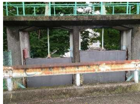
東京葛西第一水門
