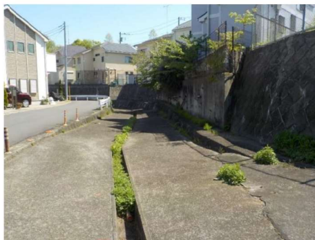
水（あいおい堀）と緑（鑓水神子沢緑地）の連続性がない
