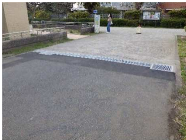
写真7 排水設備改善工事
