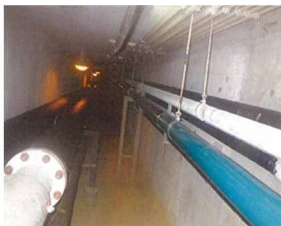
写真 20 共同溝内排水ポンプ交換
