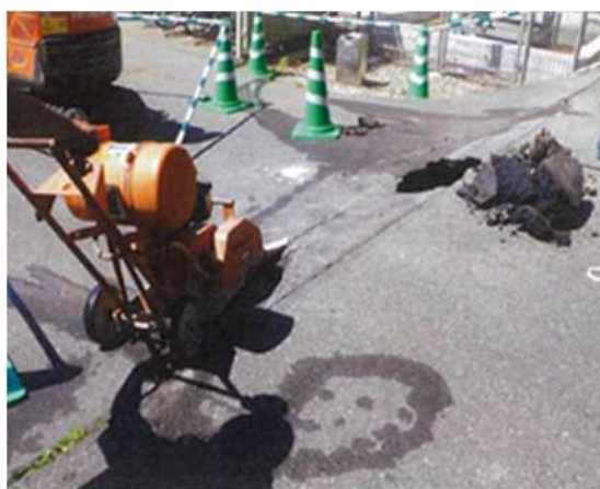
写真 18 AS 舗装陥没箇所補修
