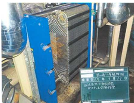
写真 19 熱交換ガスケット交換
