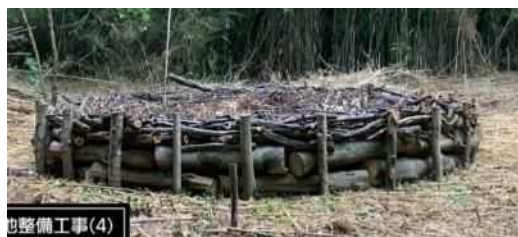
写真2 パイオネスト
