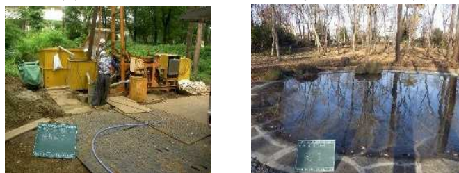
写真7 井戸設置状況
