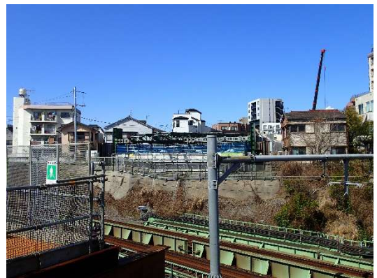
（北区田端側から撮影）
