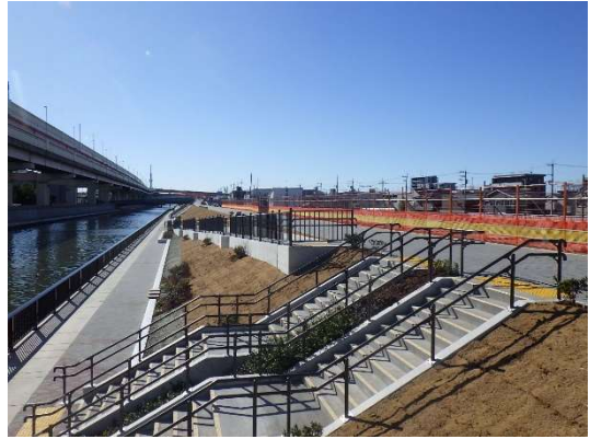
六町地区緩傾斜堤防
