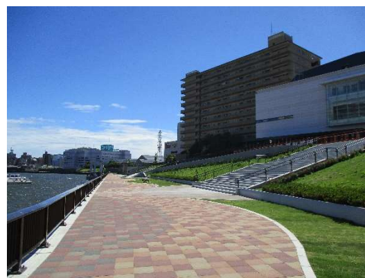
（隅田川スーパー堤防・神谷三丁目地区）
