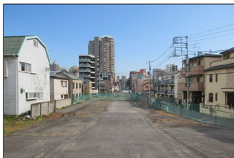
トンネル出入口付近から新目白通り方面を望む
