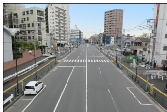
目白台二丁目歩道橋から目白台二丁目交差点を望む
