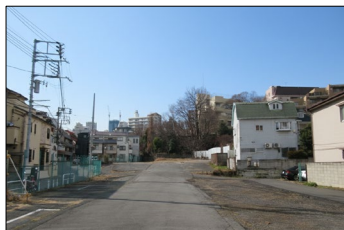
新目白通り方面からトンネル区間を望む
