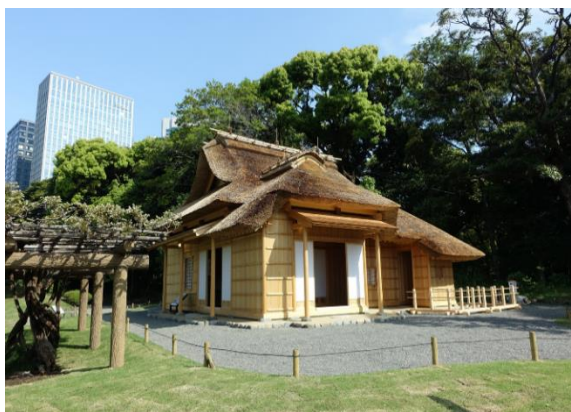
復元された鷹の御茶屋(浜離宮恩賜庭園)
