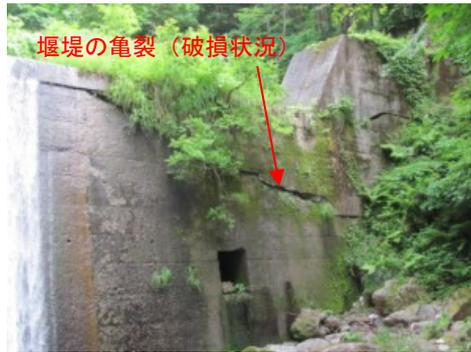
図 7.4 砂防施設の被災状態点検イメージ
