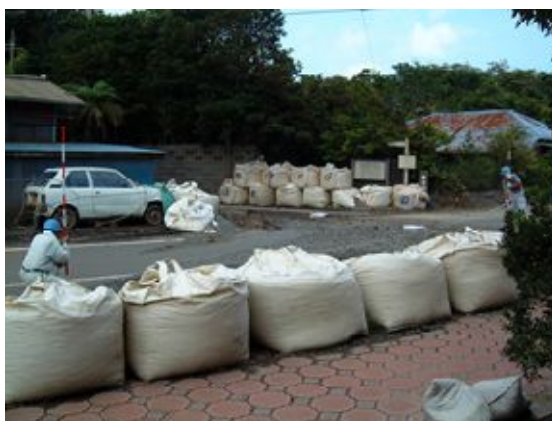
写真 4.3 大型土のう積の施工例
