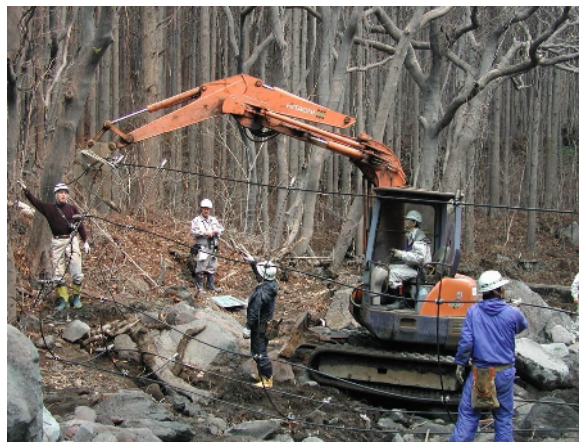
写真 4.4 簡易流木止工の施工例（とんび沢）
