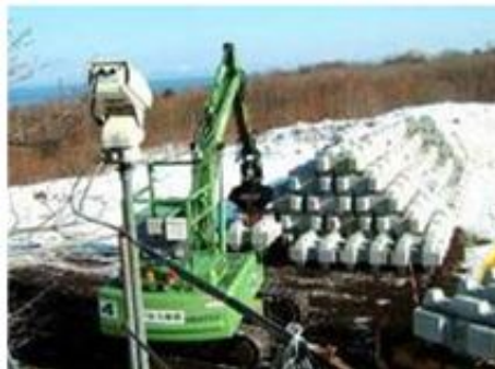
写真 4.2 PC ブロック積工の施工例
