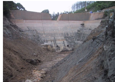
除石後の堆砂域(間川)
