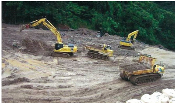
バックホー・ダンプ
