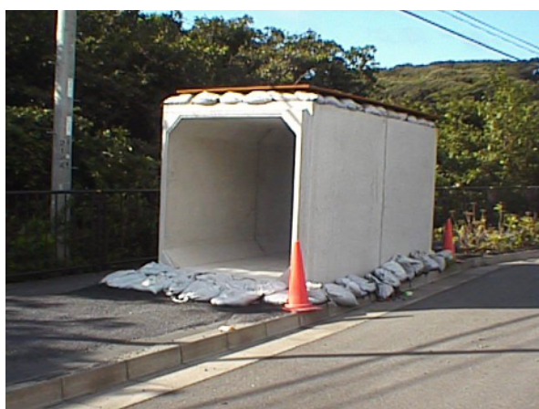
写真 4.5 現場安全対策としての噴石シェルター(左)と火砕流シェルター(右)
