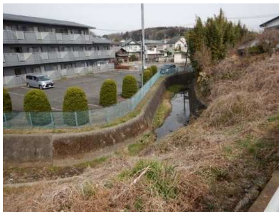
蛇行箇所（中丸橋上流）
