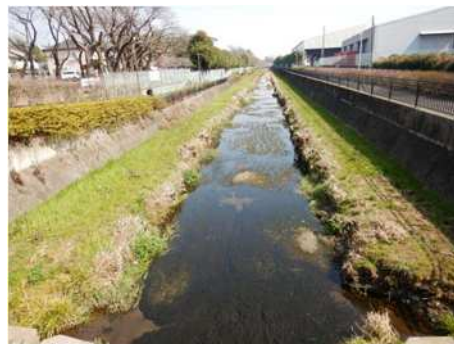
コンクリートブロック積護岸
