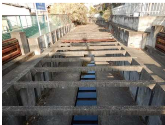
平安橋（上流側）
