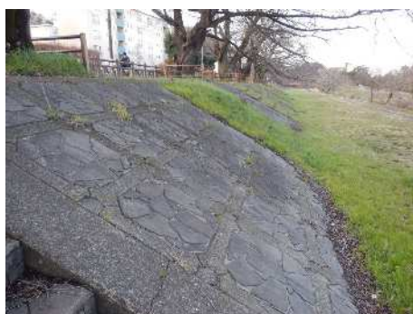
コンクリートブロック張護岸
