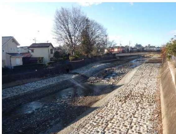
床止工（落差工）
