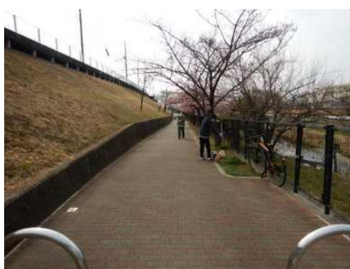
管理用通路・転落防止柵
