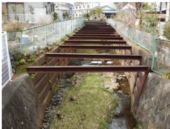
中丸一の橋（上流側）
