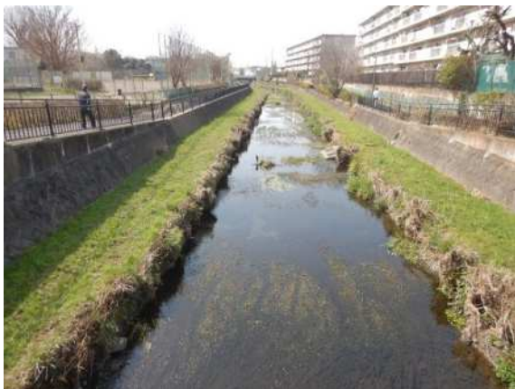
降馬橋上流側
