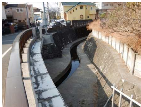
下流端（鞍尾根橋）
