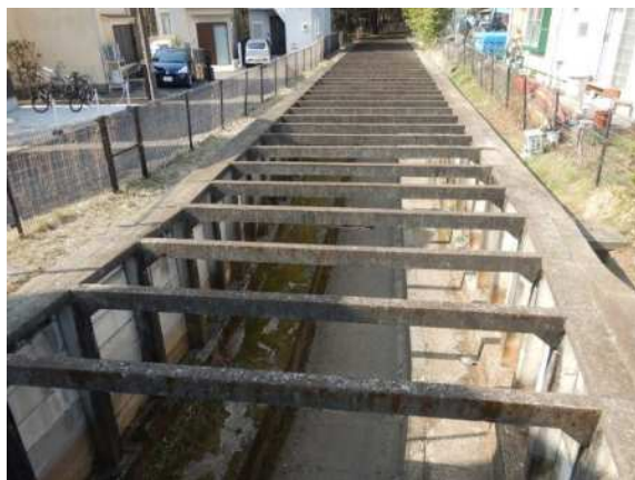
長久保橋上流側
