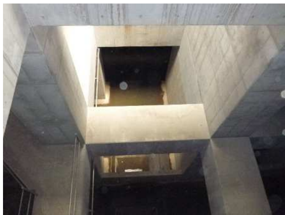
黒目橋調節池内部
