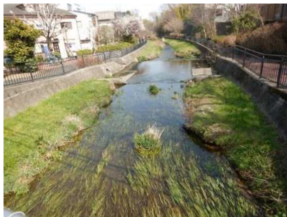
毘沙門橋下流側
