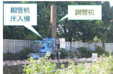
鋼管圧入イメージ図
