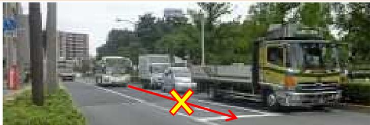
✓車線幅が狭く、右折レーンと直進レーンが同時に通行出来ないため、駅前広場へのスムーズな進入を阻害している。
