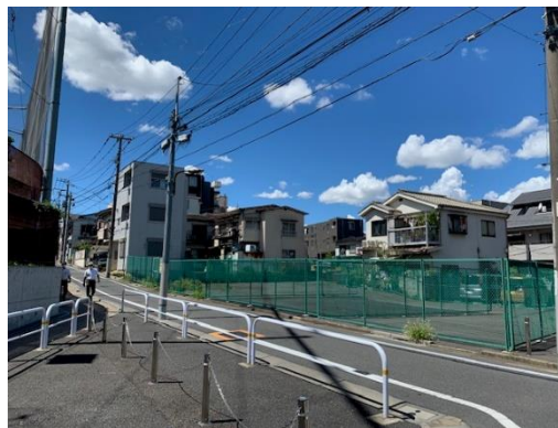
周辺道路の状況
