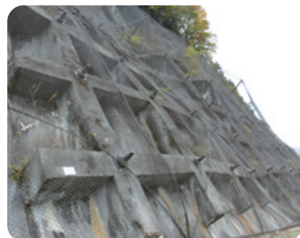
グラウンドアンカー工
