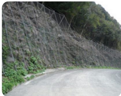
落石防止網工
