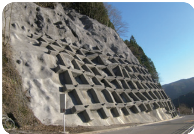
道路災害防除工事完了
