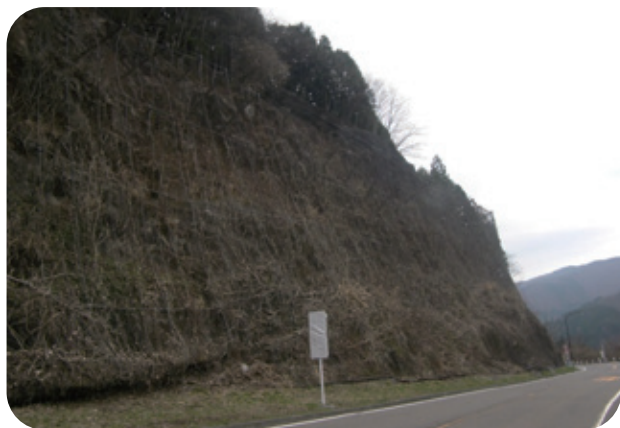
工事実施前の斜面
