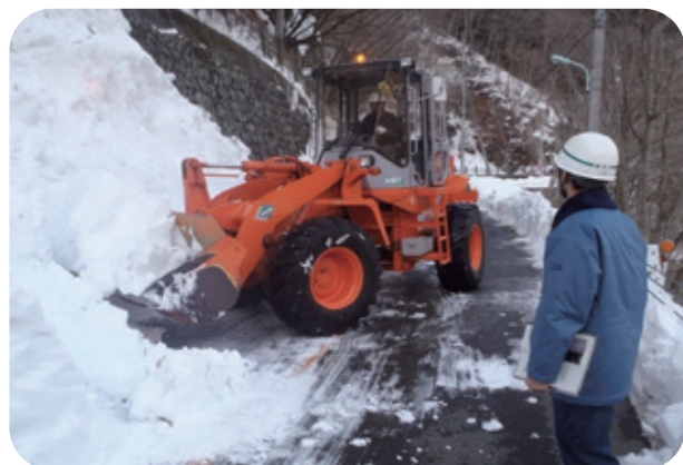
地元業者による除雪作業
