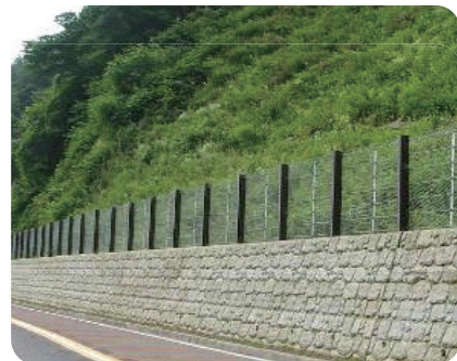
落石防護柵工
