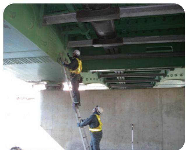
近接目視による打音検査
