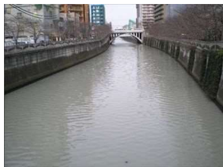
写真 2-6 新橋下流白濁状況
