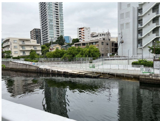
写真 2-7 東海橋防災船着場
