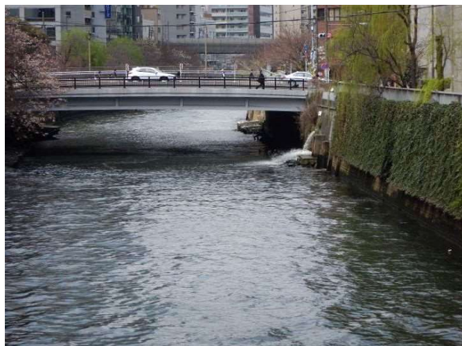
写真 2-4 地下鉄からの湧水放流状況
