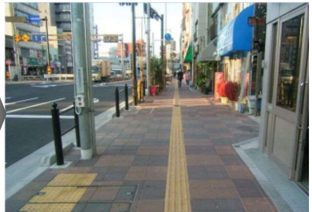
図 4-4 セミフラット形式による勾配の改善の施工例 (<南千住駅周辺>)
