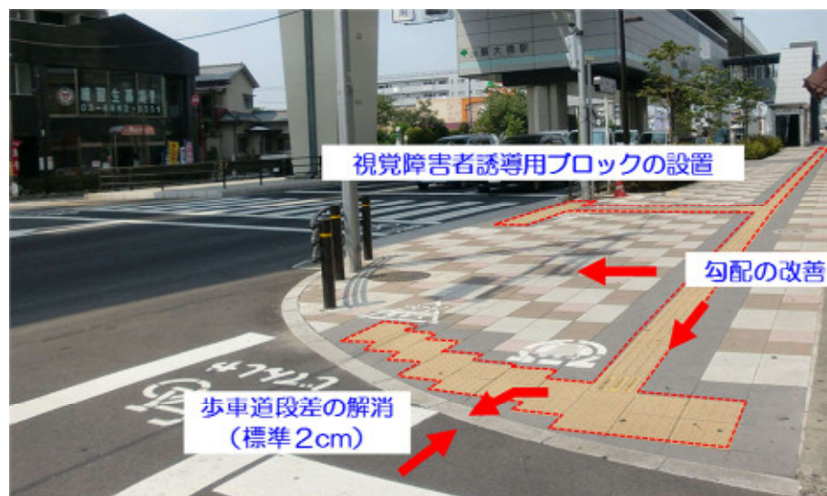
図 4-1 バリアフリー化の整備事例（尾久橋通り<扇大橋駅周辺>）
