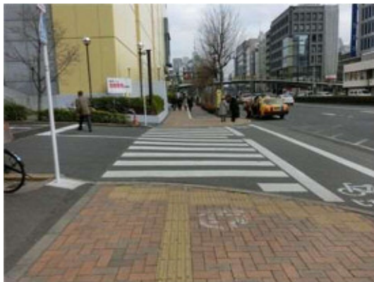
(輝度比が小さい不適切な設置事例)
