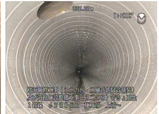
管きよ内面被覆工Φ600mm（製管工法）施工前後
