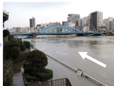
高潮時の駒形橋上流左岸 (隅田川)
