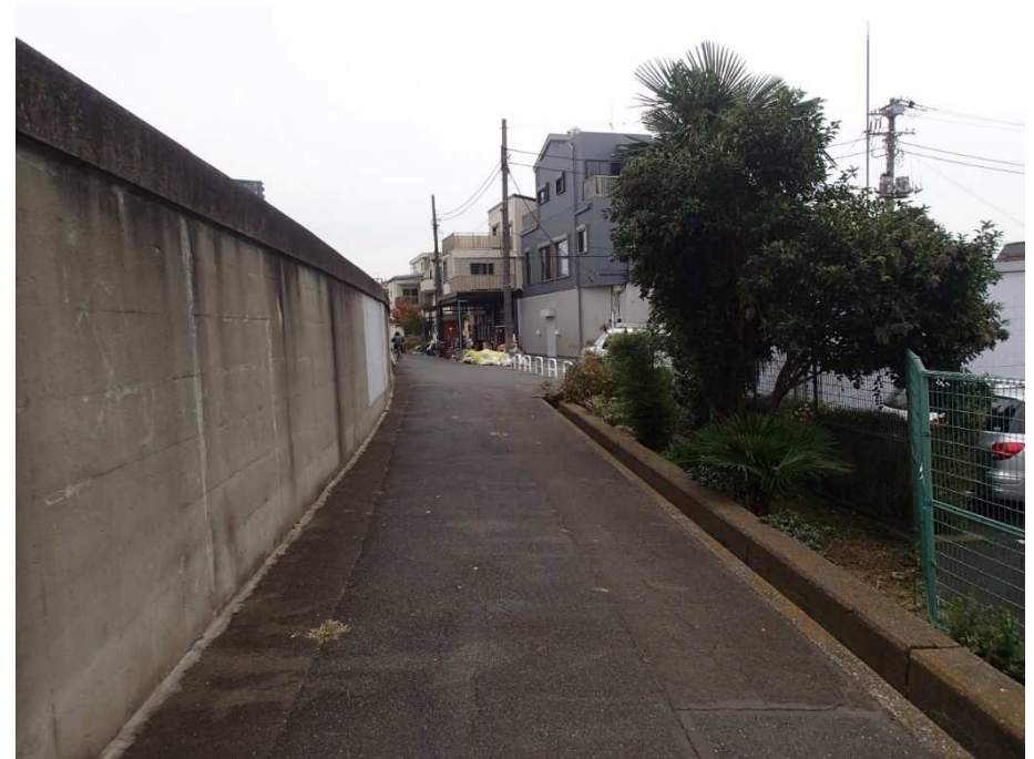
防潮堤の背後の状況（隅田川）
